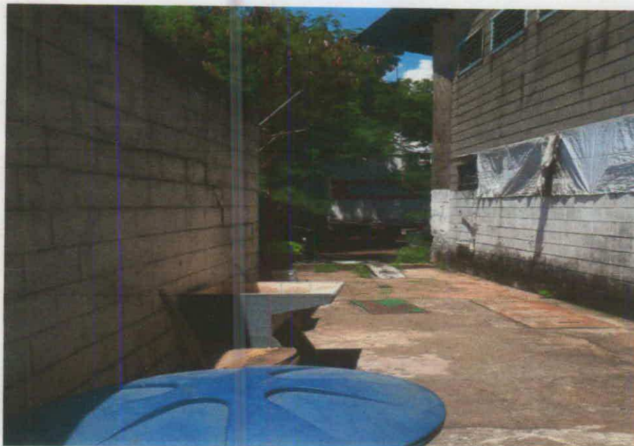
VISTA DO CORREDOR EXTERNO - FACE DOS FUNDOS DO TERRENO
