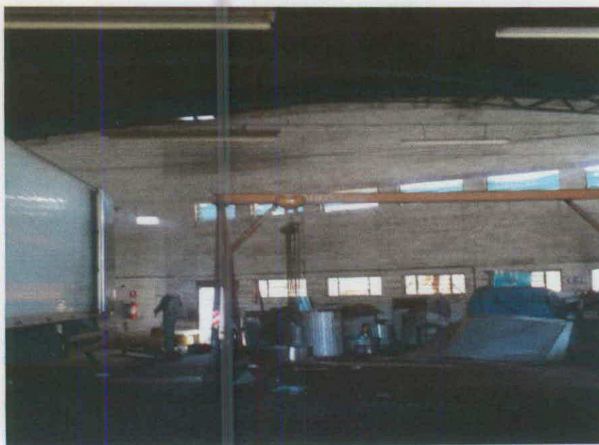
OUTRA VISTA INTERNA DO GALPÃO - OFICINA
