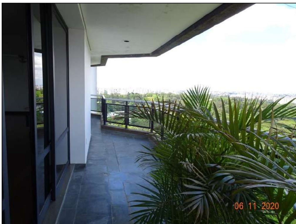
Foto 35. Vista do terraço da unidade autônoma semelhante ao avaliando do Edifício Santa Rita integrante do empreendimento "Condomínio Chácara Santa Elena". Possui piso em pedra ardósia, fechamento vertical com gradil em alumínio e vidro.
