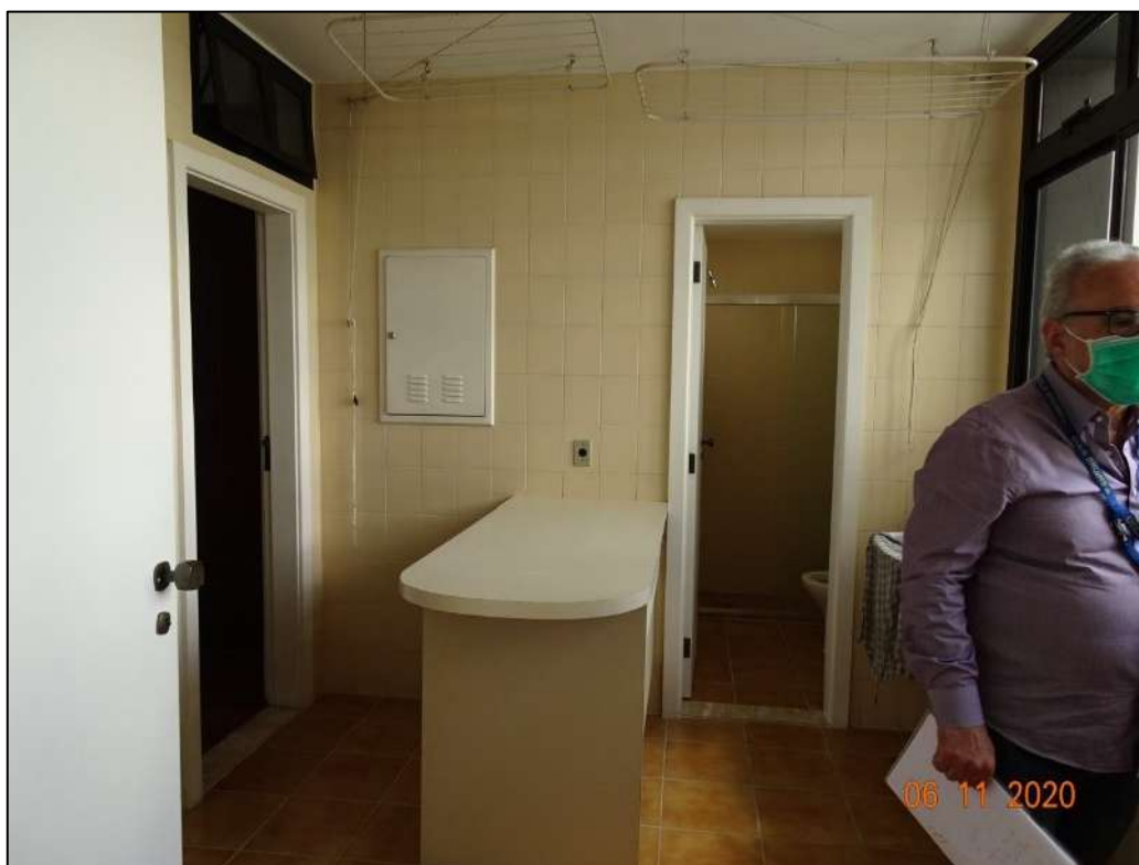
Foto 67. Vista da lavanderia da unidade autônoma semelhante ao avaliando do Edifício Santa Rita integrante do empreendimento "Condomínio Chácara Santa Elena".
