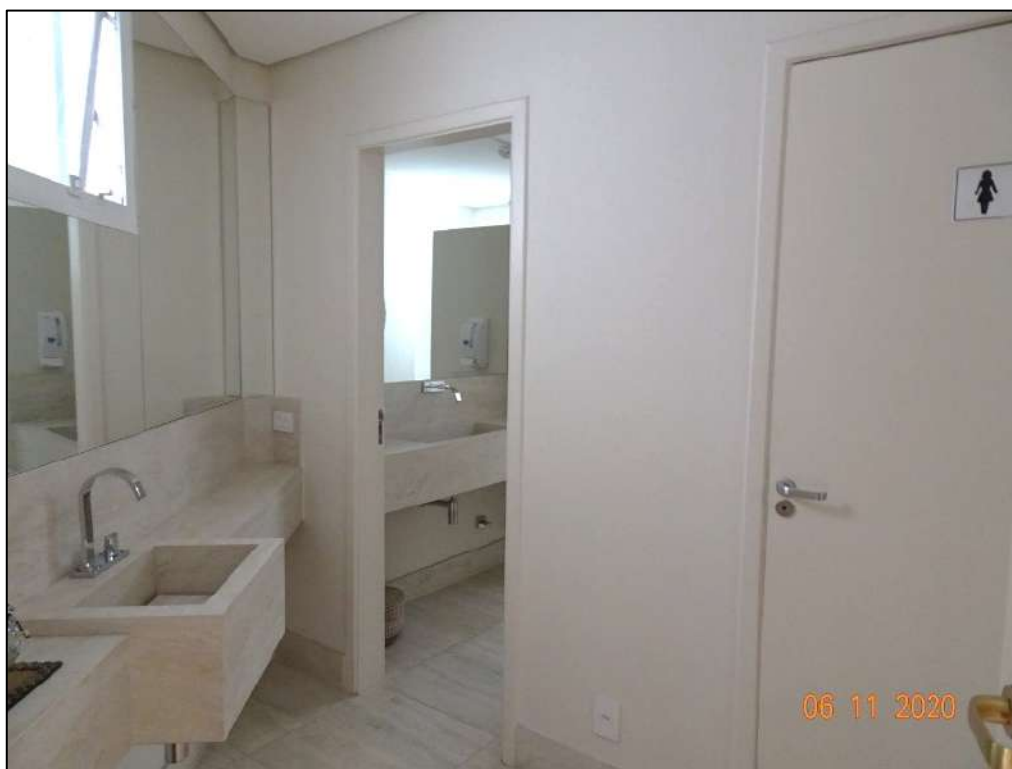
Foto 17. Vista do banheiro feminino e masculino do salão de festas do Edifício Santa Rita, integrante do empreendimento “Condominio Chácara Santa Elena”.
