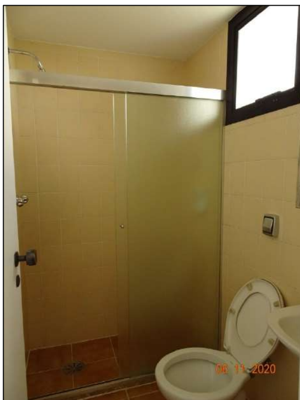
Foto 69. Vista do banheiro da empregada da unidade autônoma semelhante ao avaliando do Edifício Santa Rita integrante do empreendimento "Condomínio Chácara Santa Elena".
