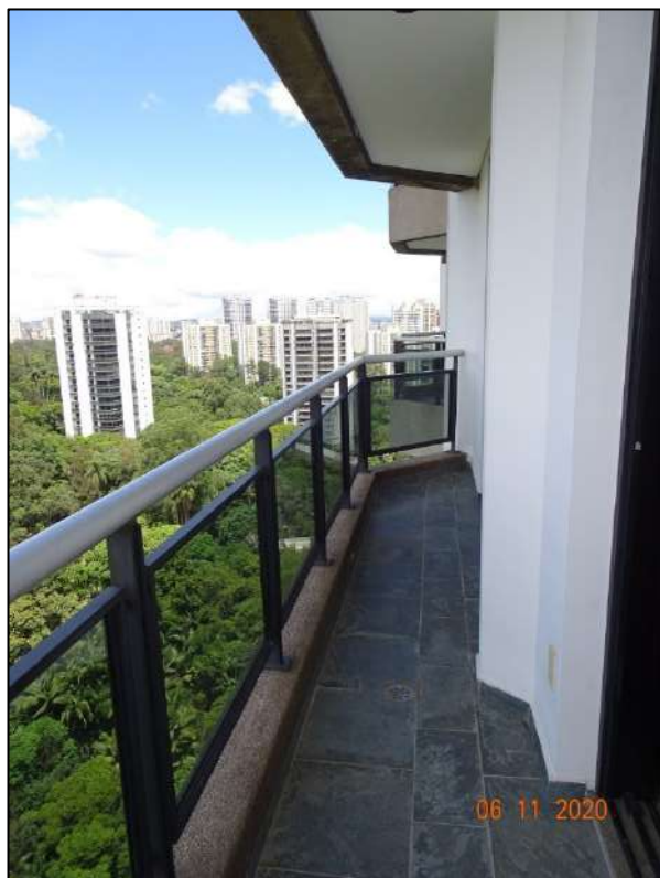
Foto 44. Vista do terraço do dormitório suíte 1 da unidade autônoma semelhante ao avaliando do Edifício Santa Rita integrante do empreendimento “Condomínio Chácara Santa Elena”.
