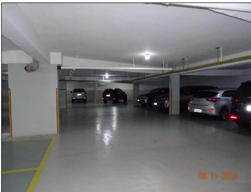
Foto 26. Vista das vagas de garagem no subsolo do Edifício Santa Rita, integrante do empreendimento "Condomínio Chácara Santa Elena".
