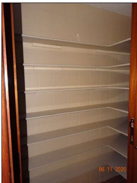
Foto 66. Vista da despensa da unidade autônoma semelhante ao avaliando do Edifício Santa Rita integrante do empreendimento "Condomínio Chácara Santa Elena".
