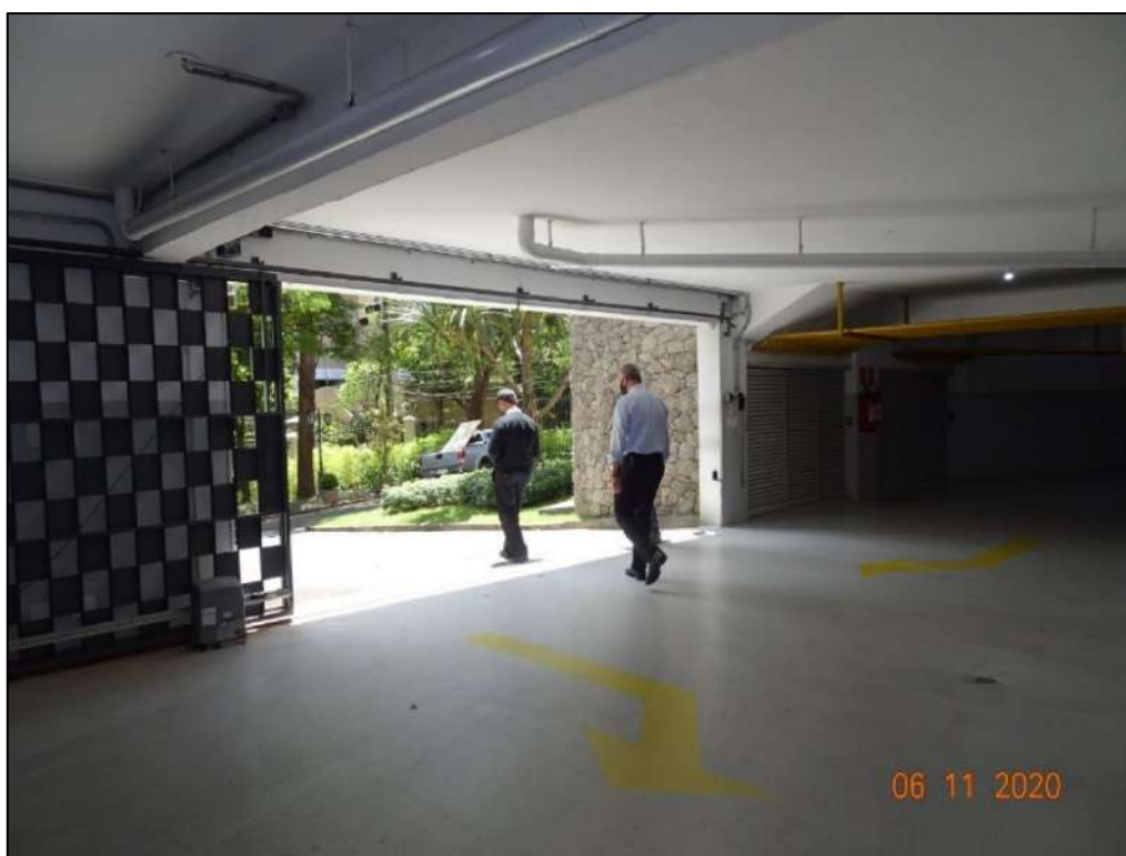
Foto 28. Vista do acesso às vagas de garagem no subsolo do Edifício Santa Rita, integrante do empreendimento "Condomínio Chácara Santa Elena".
