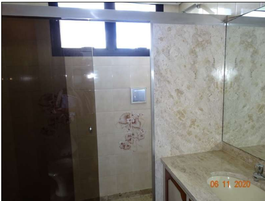
Foto 50. Vista do banheiro do dormitório da suíte 2 da unidade autônoma semelhante ao avaliando do Edifício Santa Rita integrante do empreendimento "Condomínio Chácara Santa Elena".
