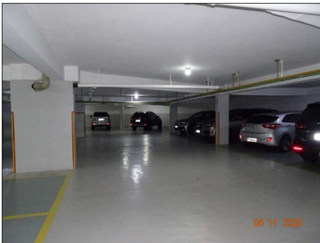
Foto 27. Vista de outro ângulo das vagas de garagem no subsolo do Edifício Santa Rita, integrante do empreendimento "Condomínio Chácara Santa Elena".
