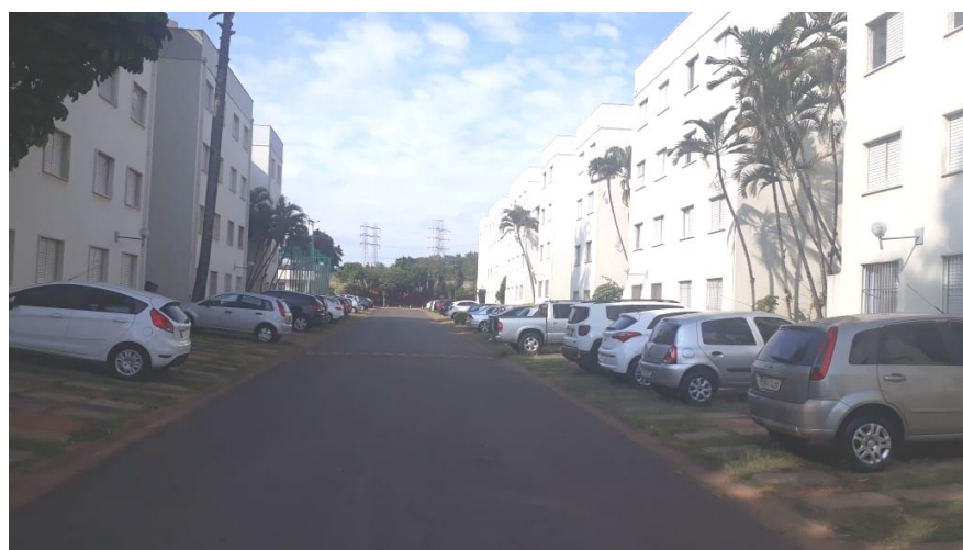
VISTA GERAL DO CONDOMÍNIO
