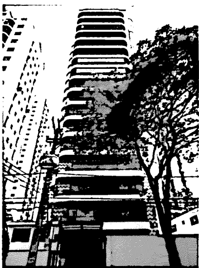
7. RUA MARCOS FERNANDES, 253 EDIFÍCIO PIAZZA D'FRANCESCA
