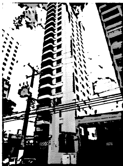
11. RUA TUIUCUE, 97 EDIFÍCIO MARRAKESH
