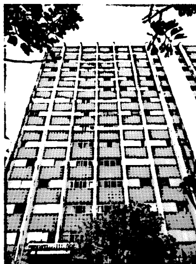
10. RUA CIPRIANO BARATA, 1451 EDIFÍCIO PALÁCIO DA INDEPENDÊNCIA
