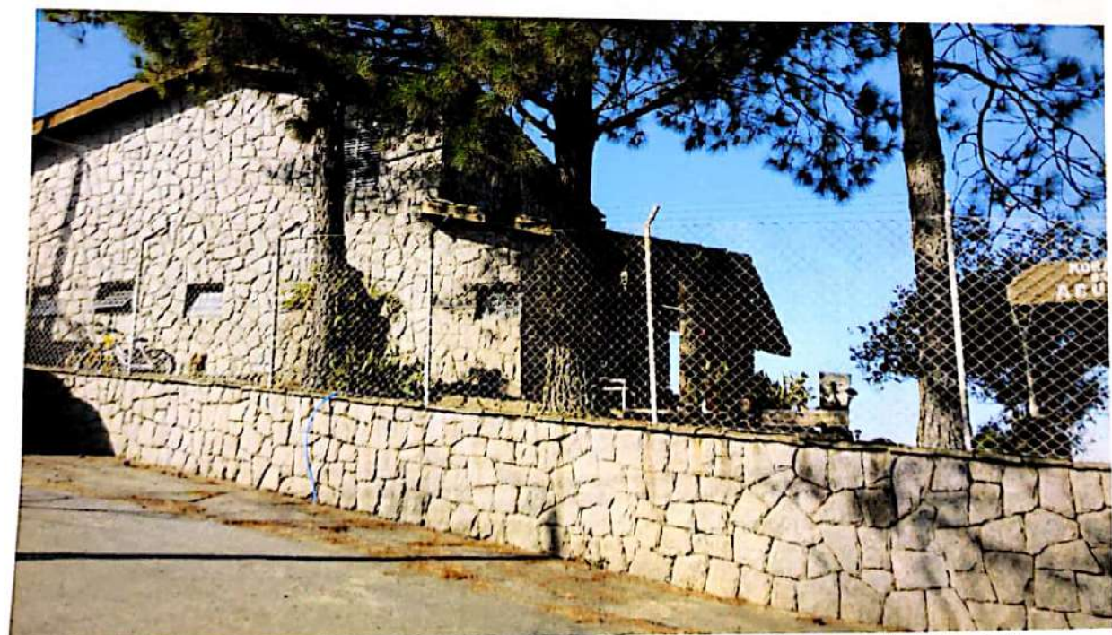
CASA REVESTIDA COM PEDRAS VISTA DA ALAMEDA
