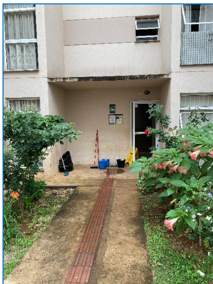
Foto 8 – Entrada para o bloco
