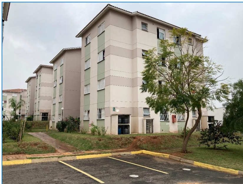
Foto 7 – Fachada do Bloco 6
