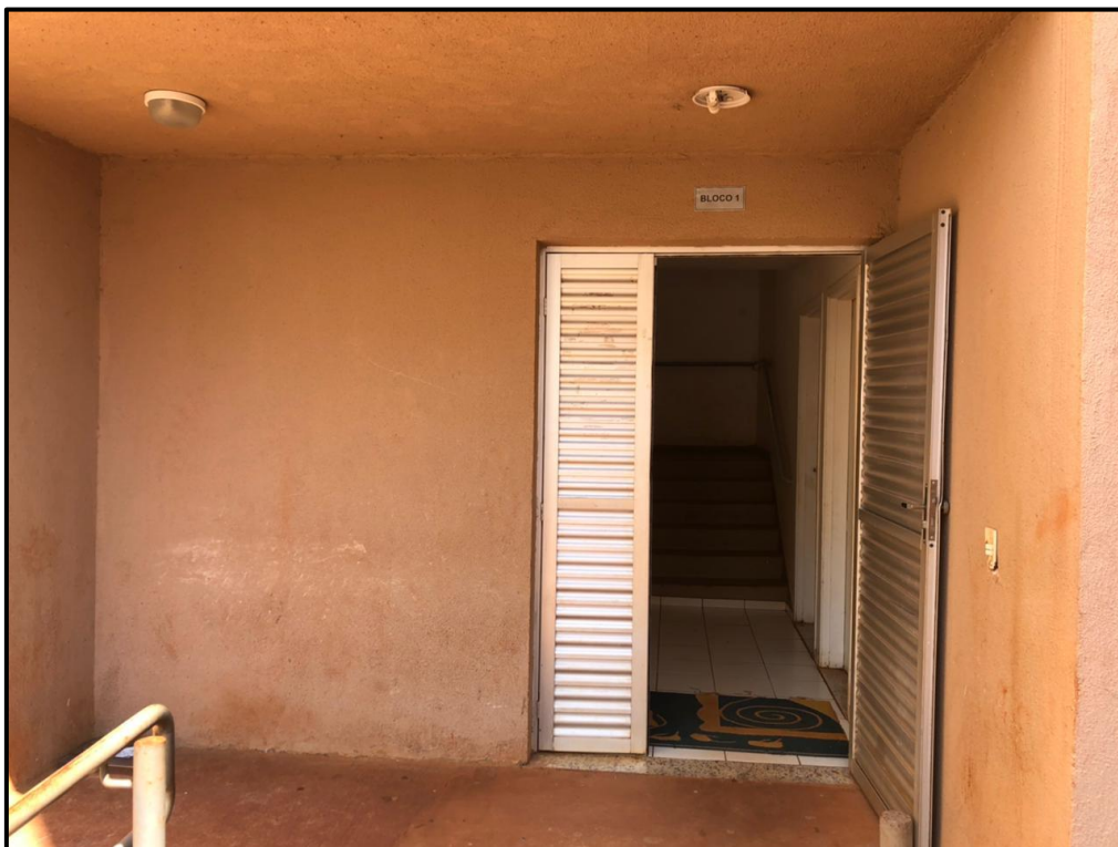
Foto 10 - Vista da entrada do Bloco 01.
