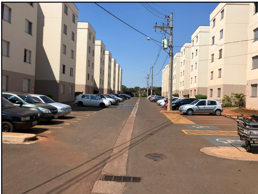
Foto 7 - Vista da área de circulação externa do Empreendimento.
