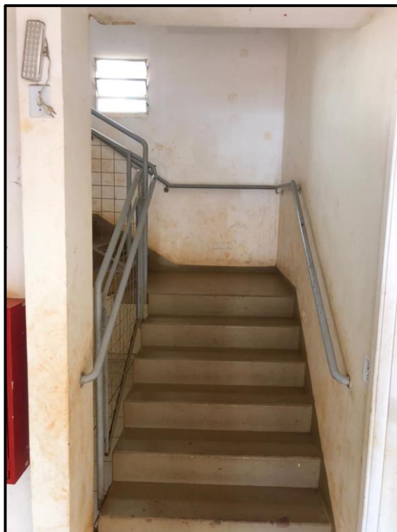
Foto 11 - Vista geral da escada de acesso ao apartamento avaliando.
