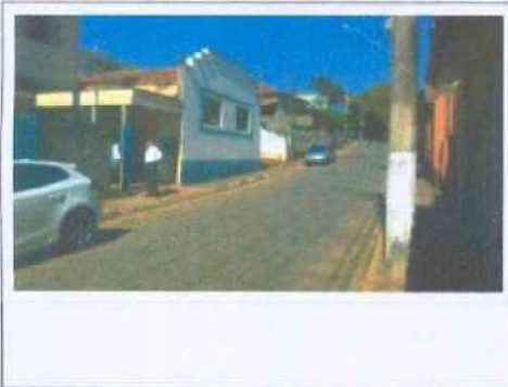
FOTO 3: Lateral direita com logradouro
