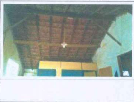
FOTO 5: Vista interna do Imóvel
