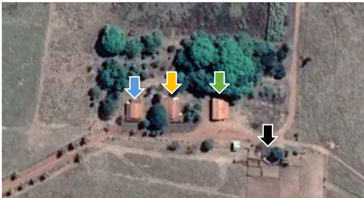
Figura 14 - Estruturas presentes - Casa para Caseiro (AZUL) / Sede (LARANJA) / Barracão (VERDE) / Curral (PRETO)
