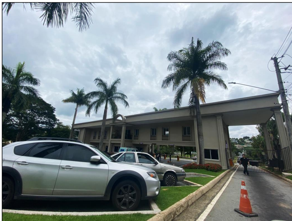
FOTOGRAFIA 01: Vista do controle de acesso do Residencial Tamboré 2.
