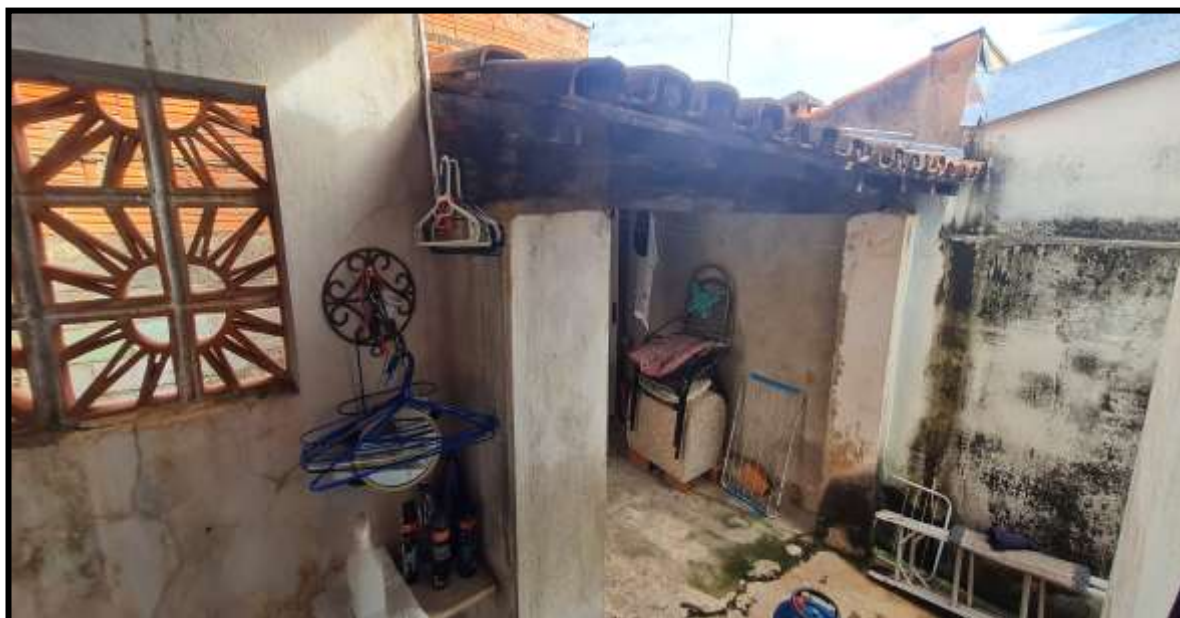
11. Vista da cobertura existente nos fundos do terreno.
