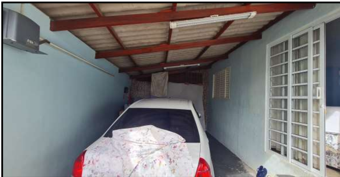
5. Cobertura da frente e fachada da residência.
