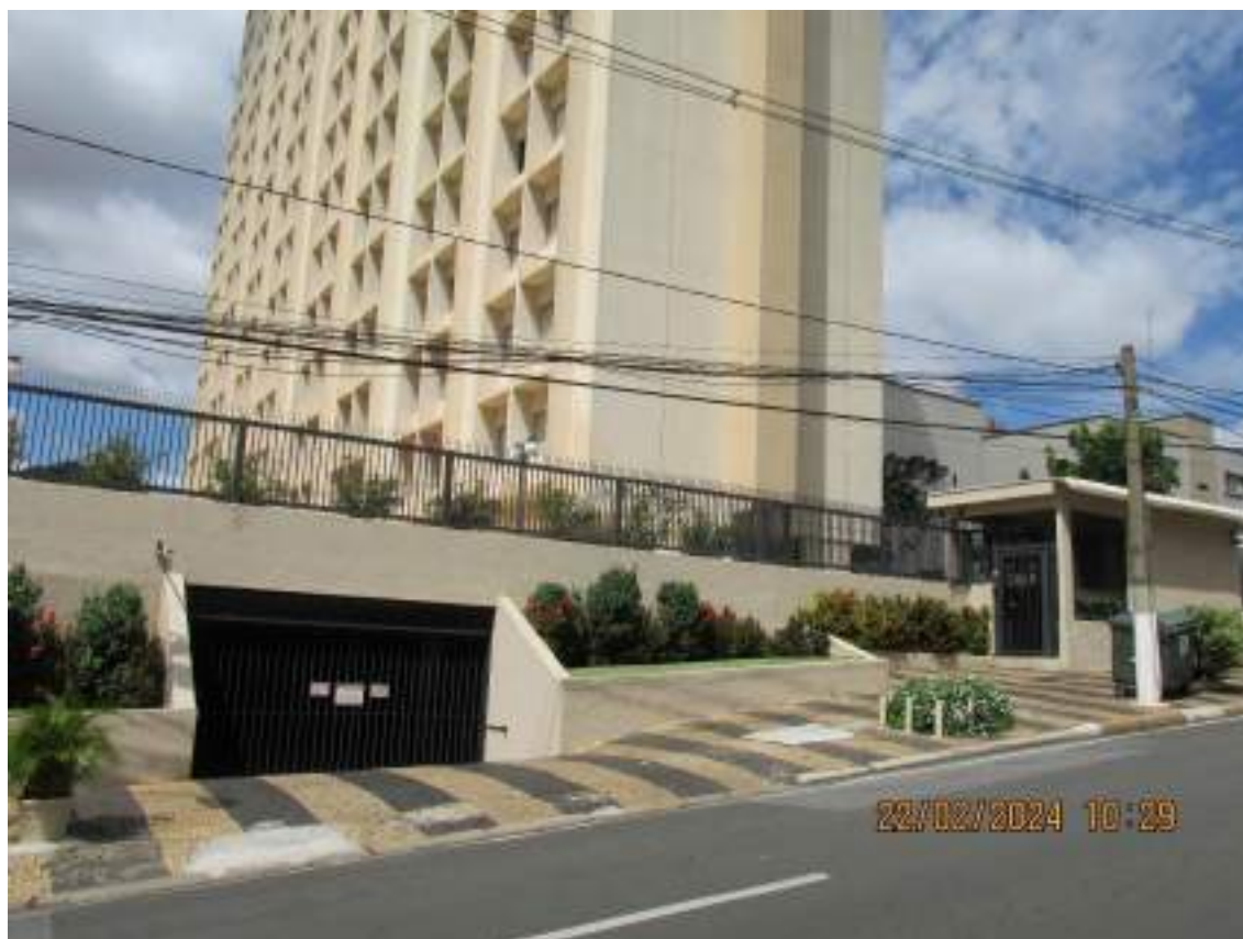
Fachada da Portaria e Entrada Garagem (subsolo)
