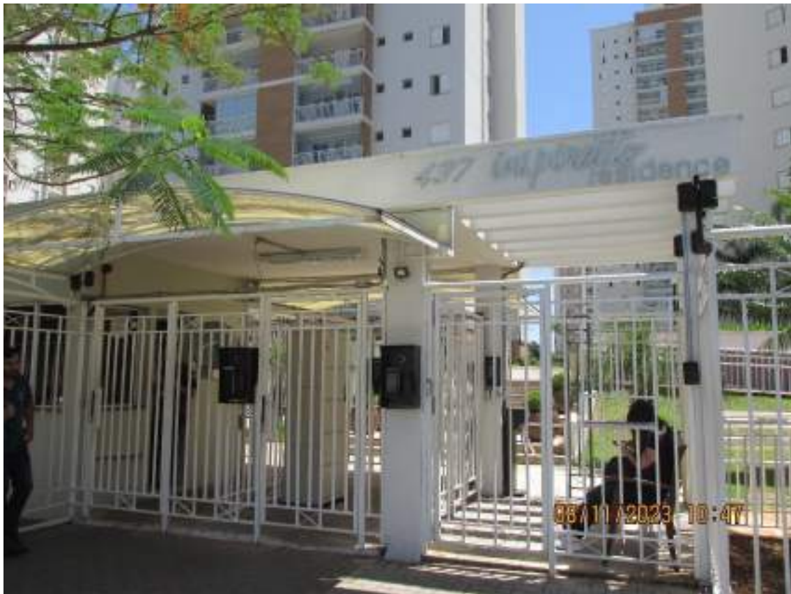
Fachada da Portaria
