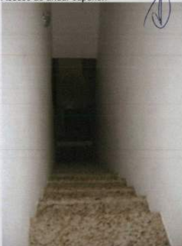
Acesso ao andar superior.
